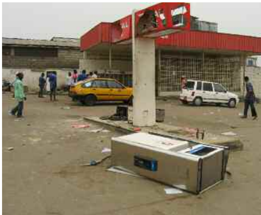
STATION SERVICE DÉTRUITE À DOUALA
