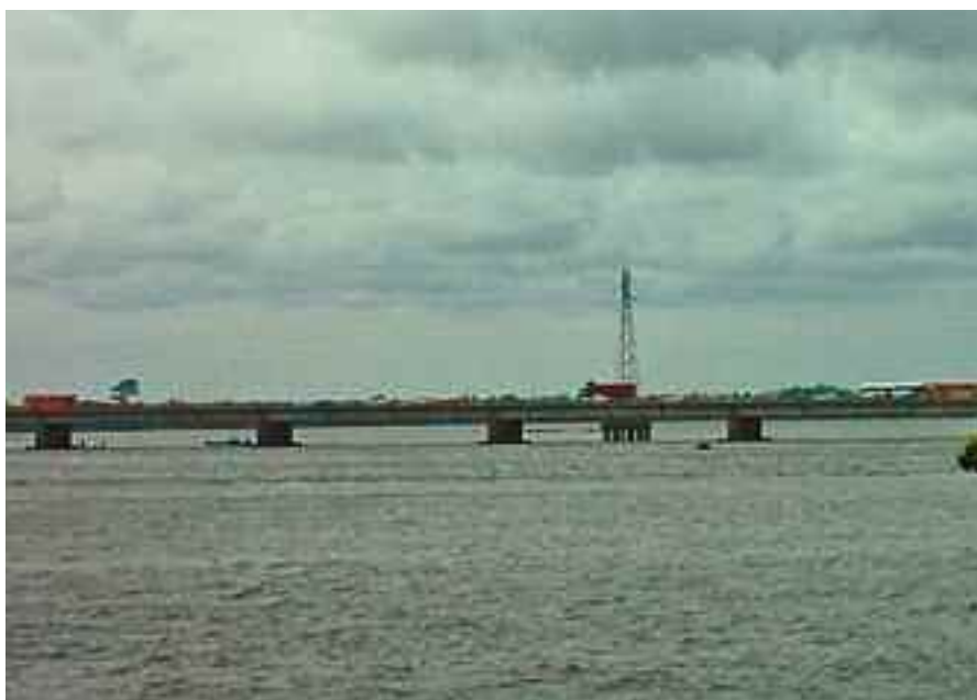
PONT DU WOURI, DOUALA
